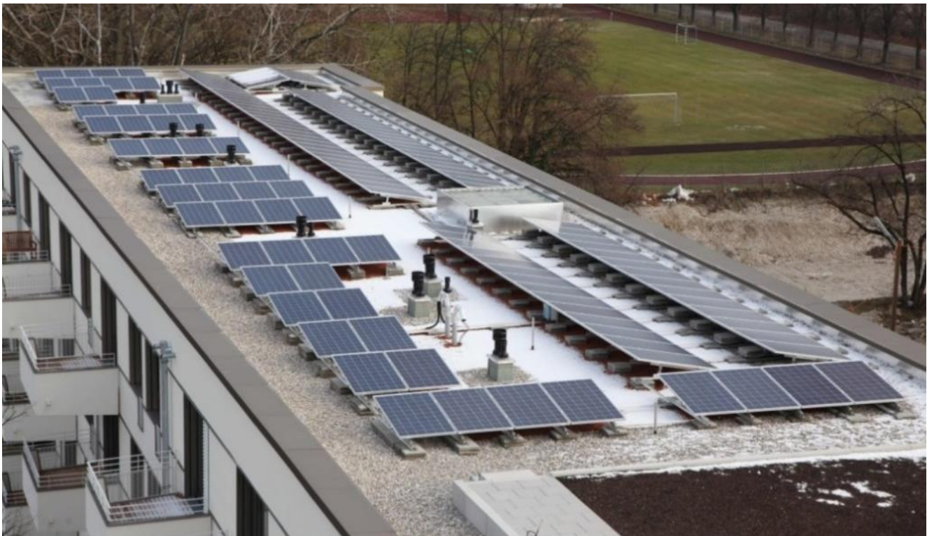
Die individualisierte Ausrichtung der Module modelliert den Strombedarf im Gebäude und optimiert damit den Eigenverbrauch
