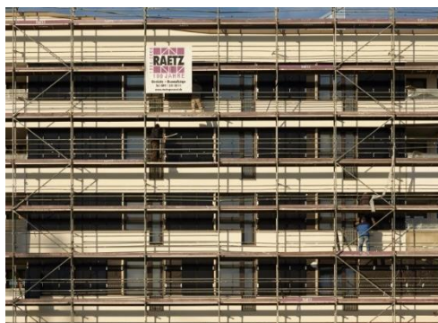
Zügige Montage der Module als letztes Gewerk
